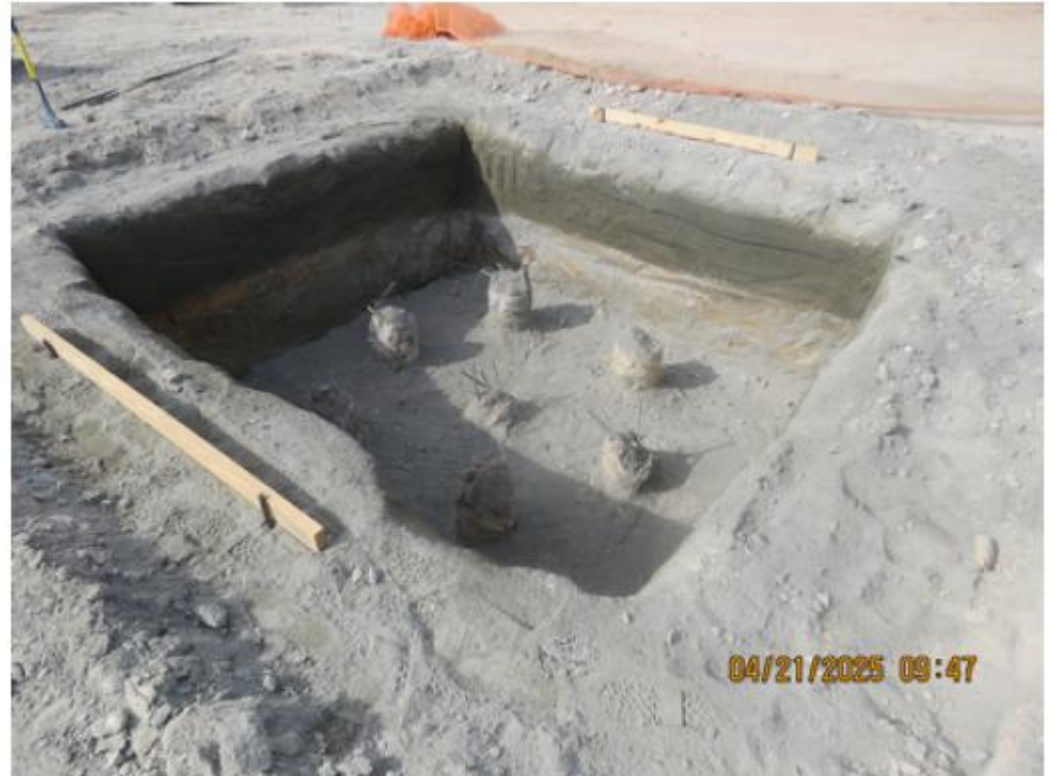
Pile cap Awaiting Rebar and Ready to Pour
